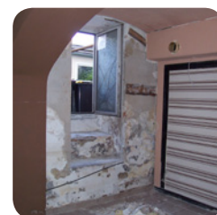
Goethestraße 51: Fenster freigelegt
