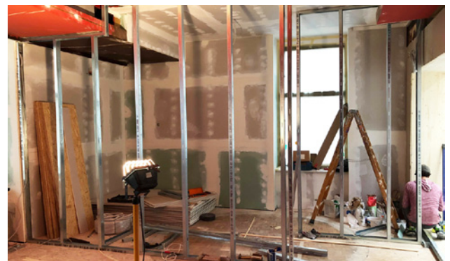
Der Beratungsraum entsteht
